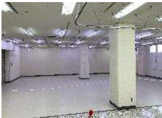
アメ横ビル2階（空きテナントスペース）
